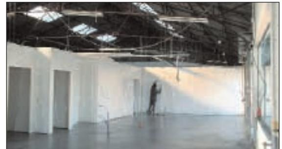
2 Une dalle de 20 cm en béton a été coulée sur toute la surface à exploiter et des panneaux sandwich ont fait le reste.
